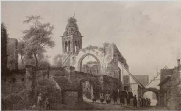
Abb. 3– Ruine der St. Jakobus Pfarrkirche Blick Richtung Osten. Erhalten sind noch der Turm sowie die Mauern des Ostchores. Reste der Mauern des südwestlichen Kirchenschiffes bilden die Abgrenzung eines dort inzwischen entstandenen Friedhofs. Quelle: Franz Stöber (1787), Ölgemälde, aus Ludwig Anton Doll / Günter Stein (1991): „Es ist Speier ein alte stat“. Ansichten aus vier Jahrhunderten. 1. Aufl.
