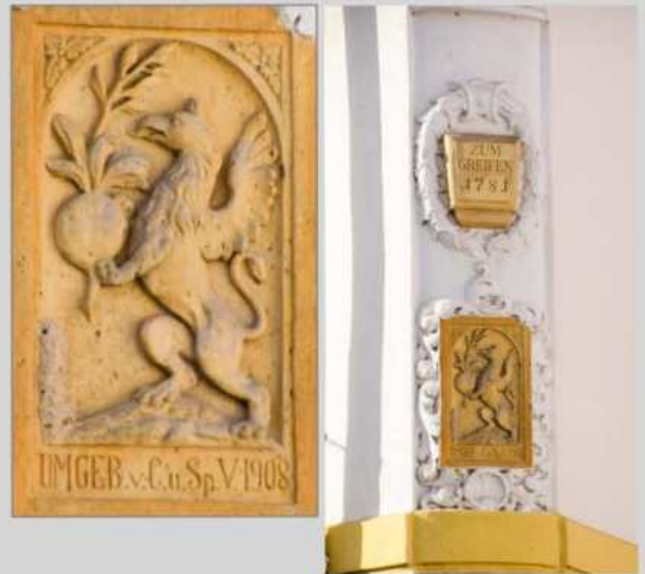
Abb. 2– Spätbarock eingefasste Plaketten am „Haus zum Greifen“ Foto: M. Maase (2024)
