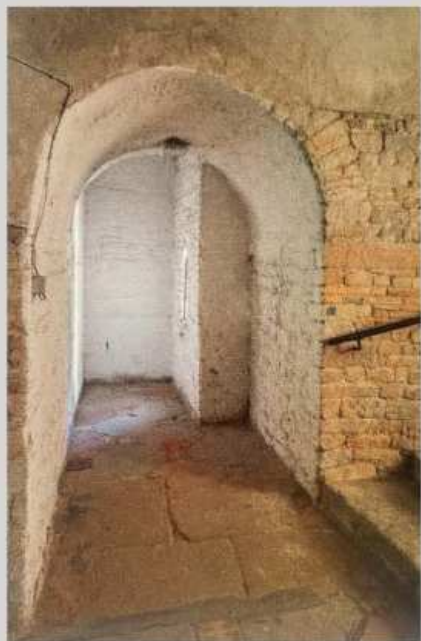
Abb. 7– Innen: Verbindung zum Übergang zur Bischofspfalz im Inneren des nördlichen Ostturms
