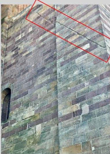
Abb. 6– Rille, wo das Schrägdach des Übergangs ans nördliche Querschiff anstieß
