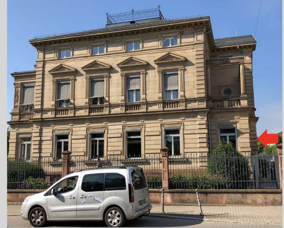
Abb. 1 – Foto C. Benz (2021) Ehem. Villa Sick, Bahnhofstr. 17
