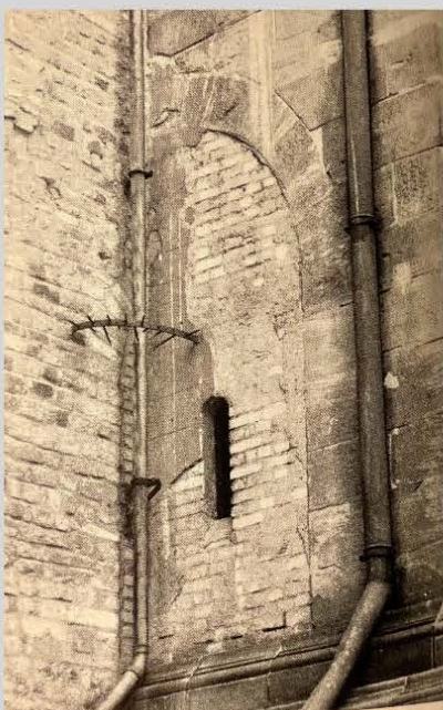
Abb. 8– Außen: Ehemaliger Zugang (heute mit Backstein vermauert) vom Verbindungsgang der Bischofspfalz in den nördlichen Ostturm
